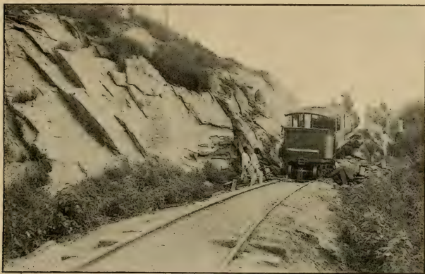
Fig. 13. — Estrada de ferro perto de Senador Pompeo no Ceará onde um desmoronamento e a perda de uma locomotiva foi devido á estrutura geologica.
